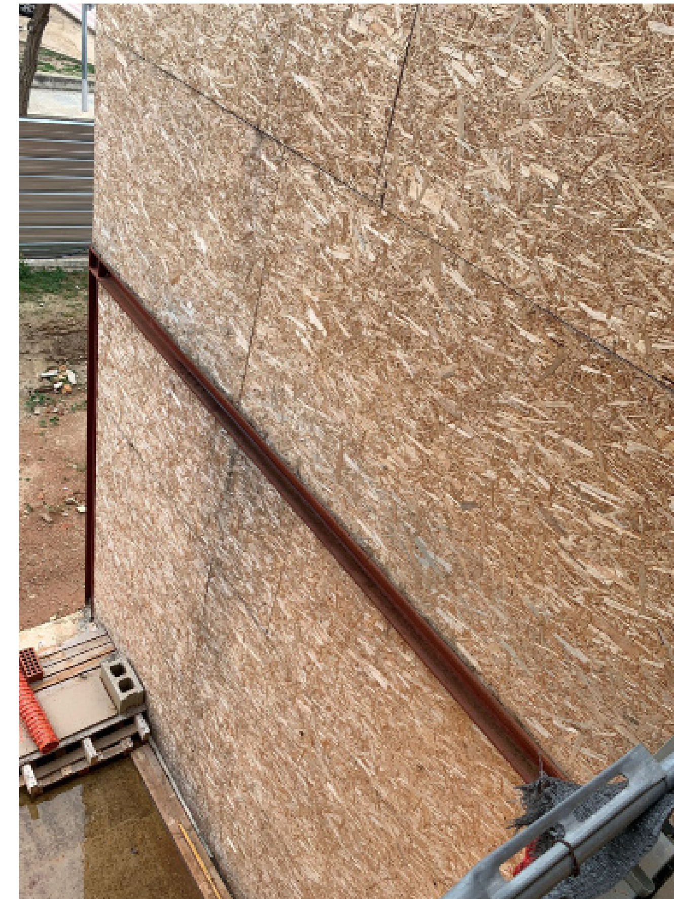
ESCALA 1 façana oest: alineació correcta de la placa de OSB amb la viga.
