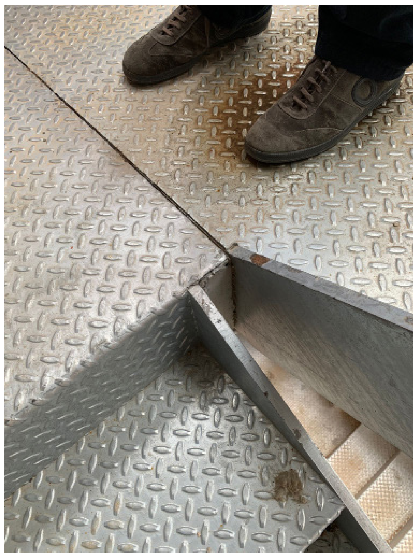
S'ha d'estudiar com es col·loca la xapa de l'escala: en alguns punts es plega aper damunt de l'estructura de l'escala i en d'altres es talla abans.
