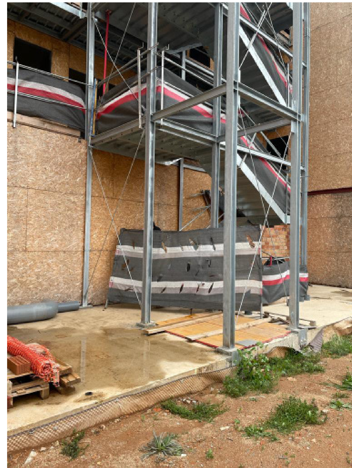
S'ha de recol·locar la creu al pòrtic del costat (ascensor) en PB.
