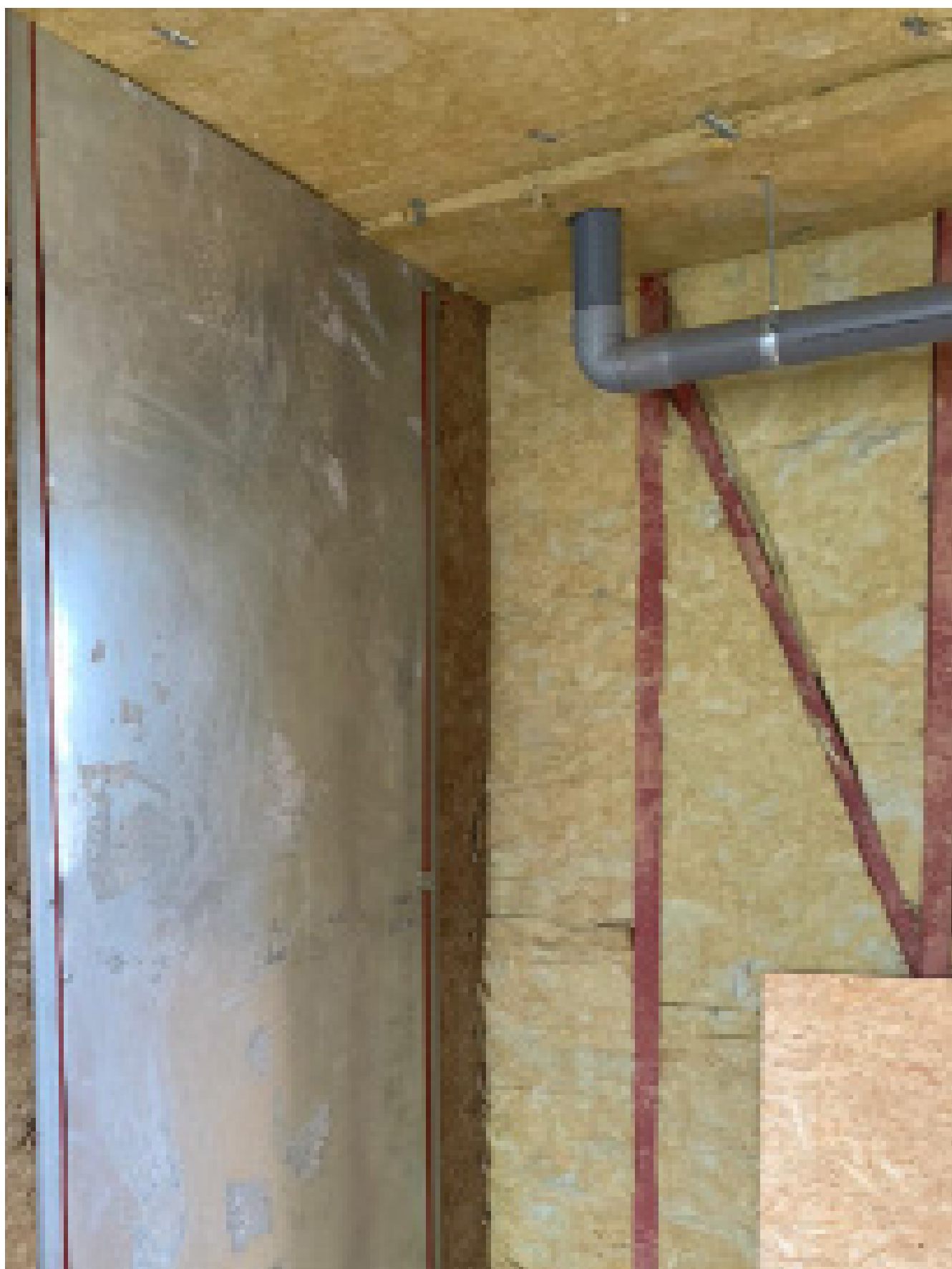
BLOC B - ESCALA 2 - P3 - 4t: Les plaques d'aïllant despengen en excés.
