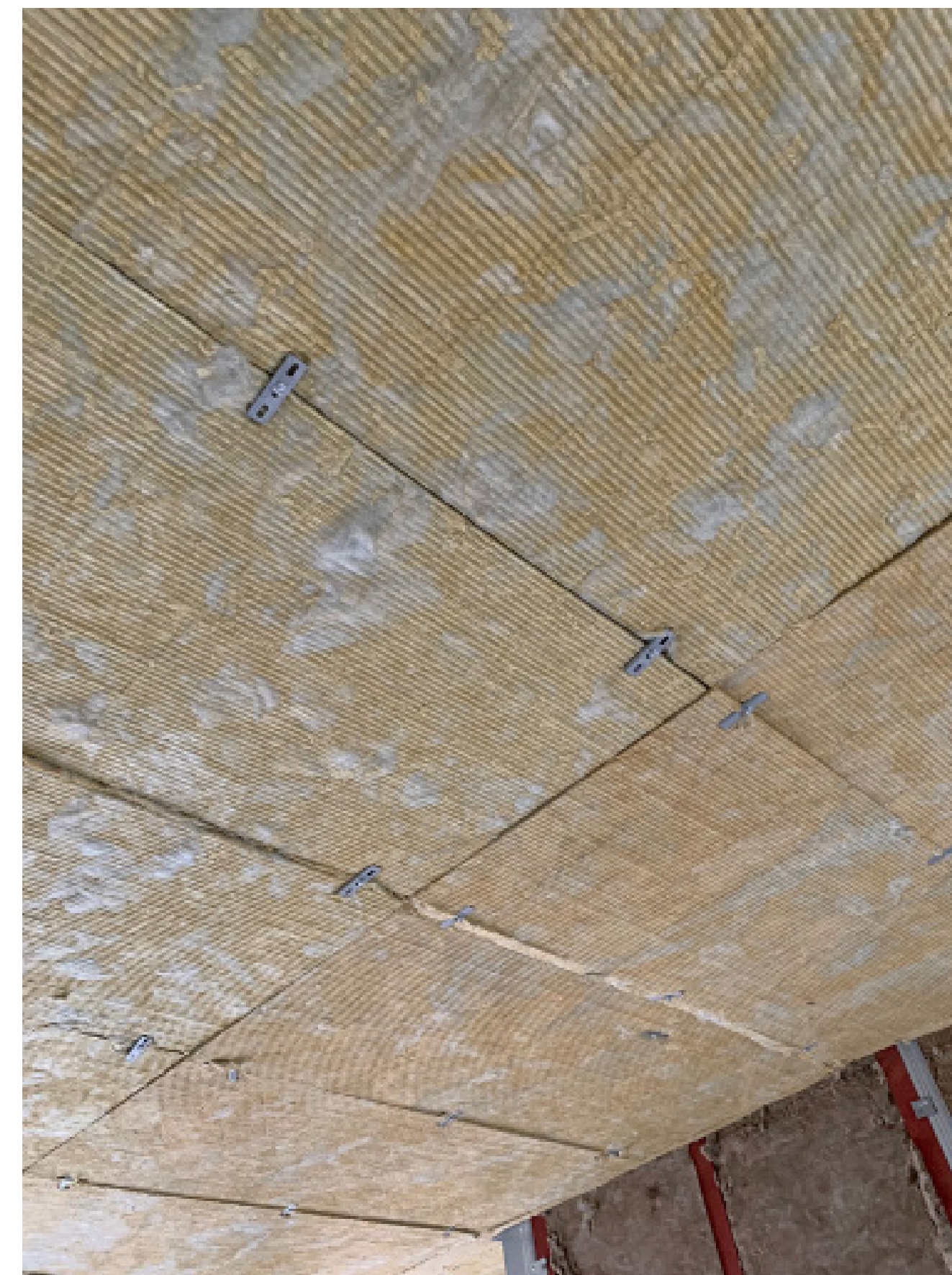
Aïllant en sostres presenta taques estranyes, s'ha de portar a laboratori per saber si és apte o no.
