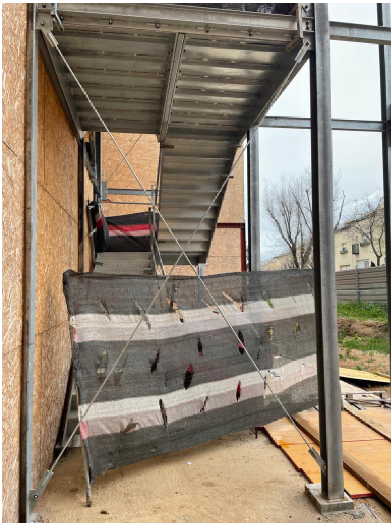
Creu per a rigiditzar l'escala (ESC.1, ESC.2 i ESC.3) mal col·locada.
