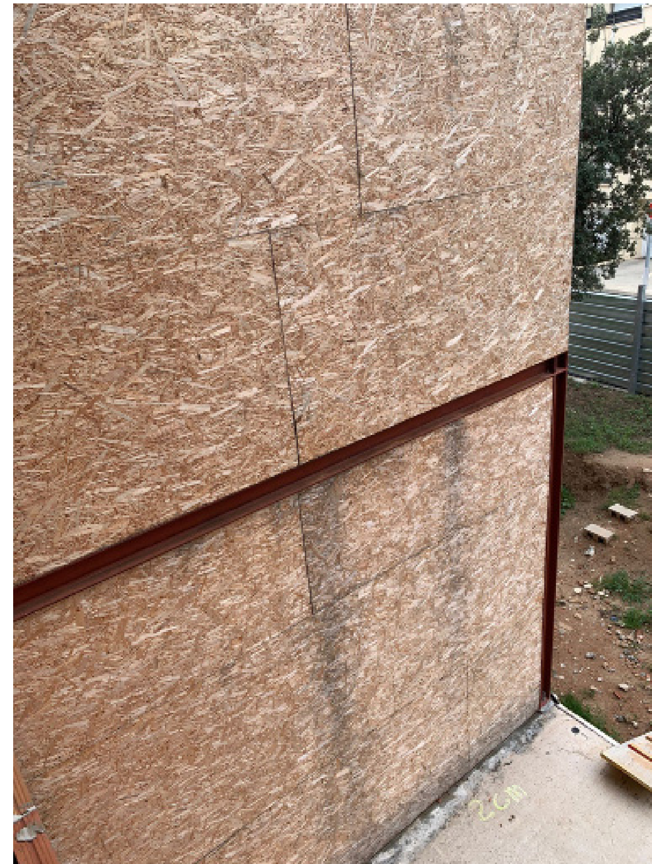
ESCALA 2 façana est: canvi d'alineació, el OSB s'ha abombat, recreixent per sobre la viga.
