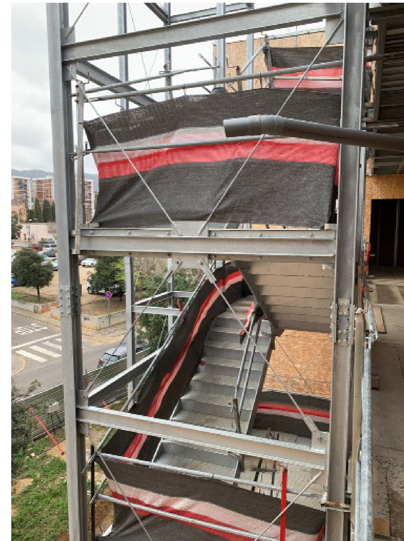
La creu dels replans a cada escala (ESC.1, ESC.2 i ESC.3) està mal col·locada.
