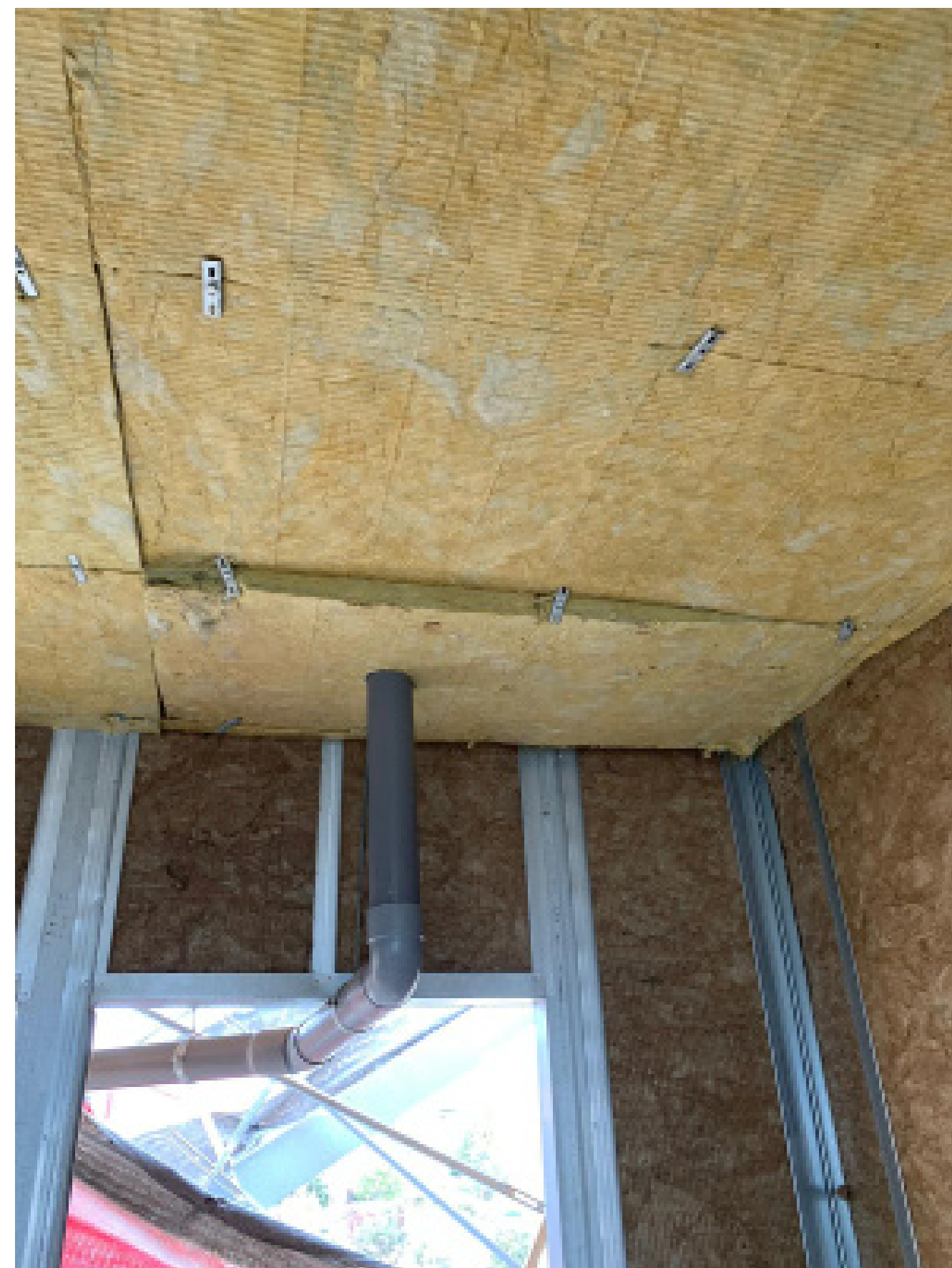
BLOC B - ESCALA 2 - P3 - 3r: Les plaques d'aïllant despengen en excés.
