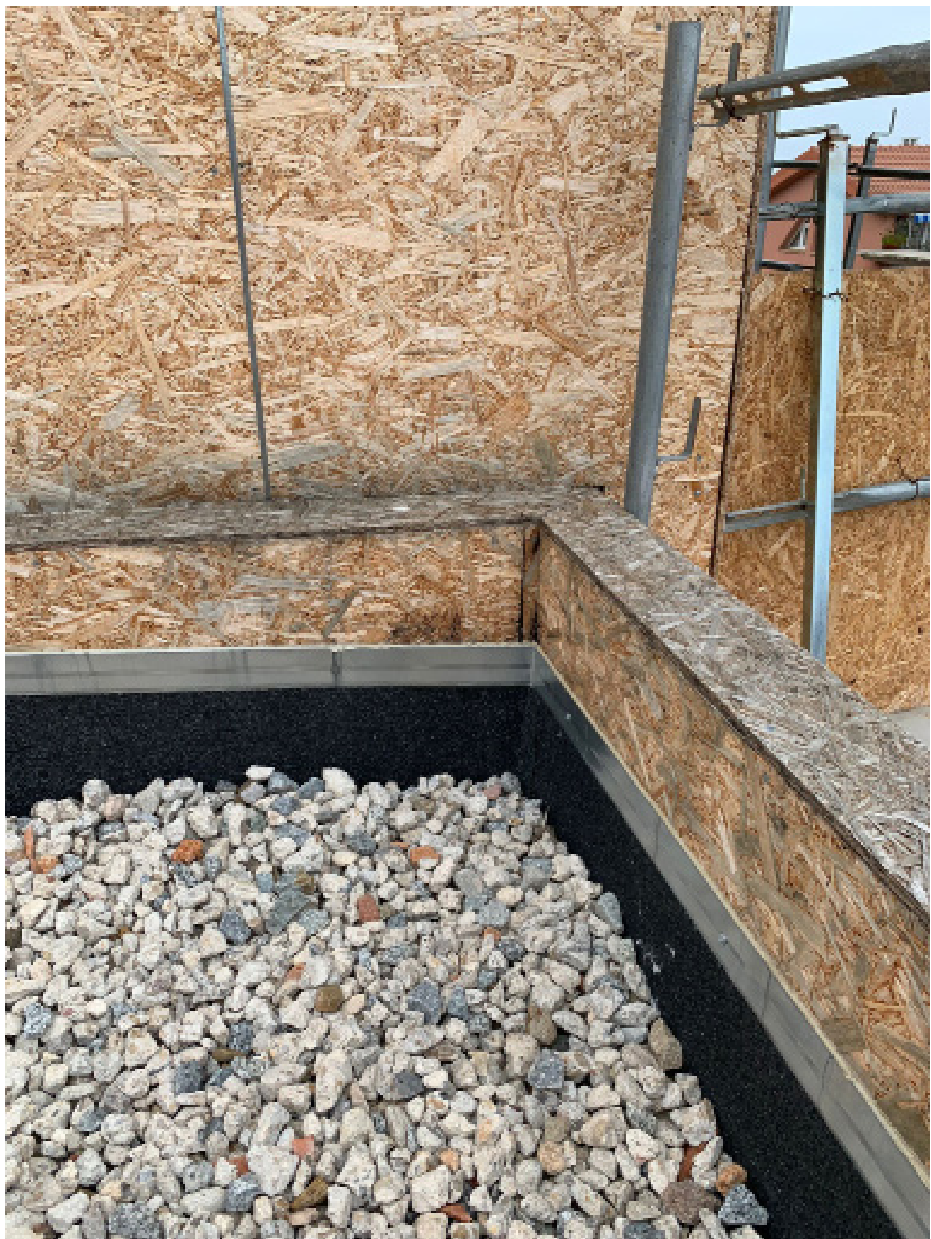
Muret de coberta: refer plaques en horitzontal, plaques en vertical es mantenen.
