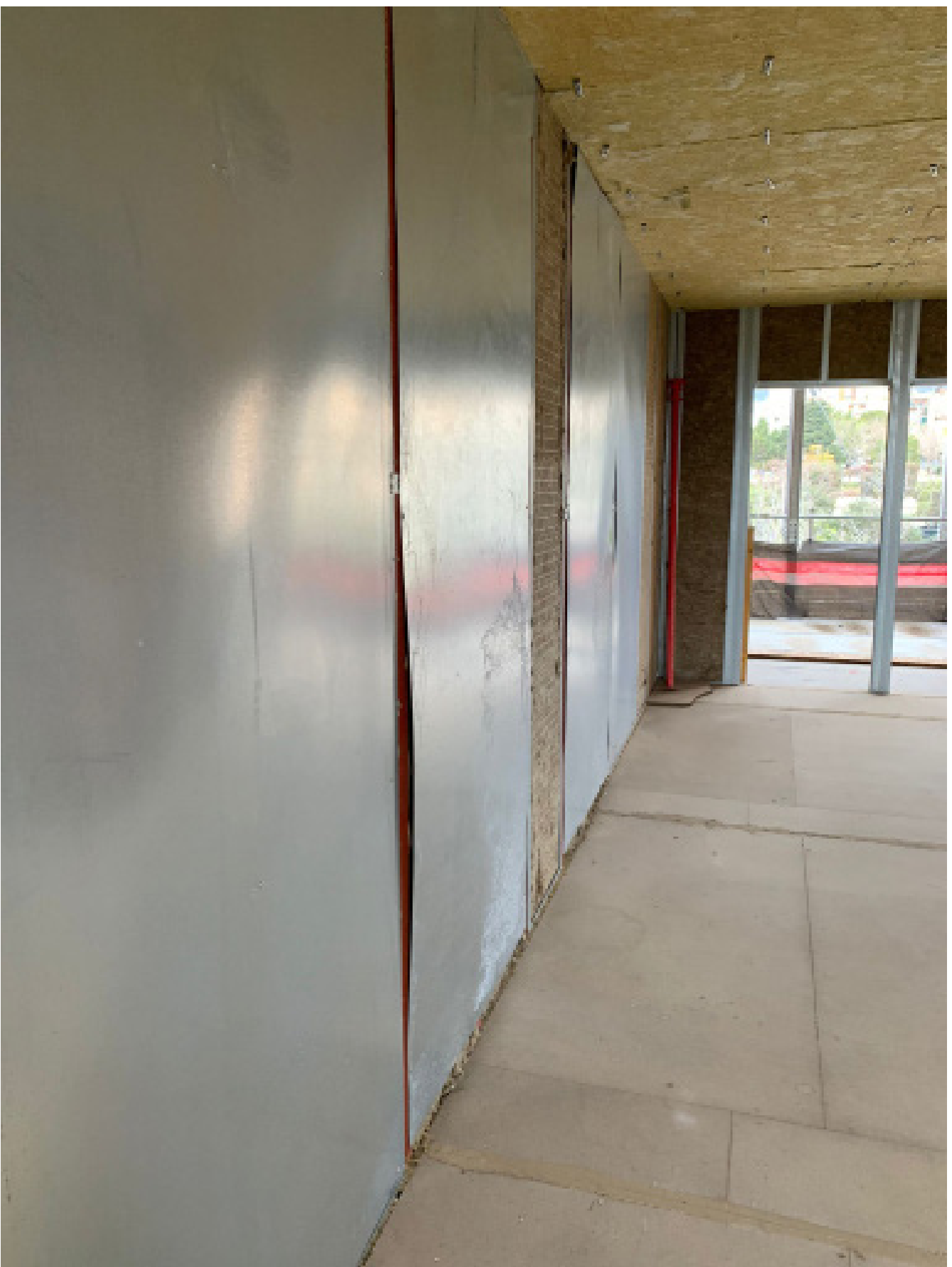
Xapes antiintrusió abombades, falta atronillar-les pel centre.
