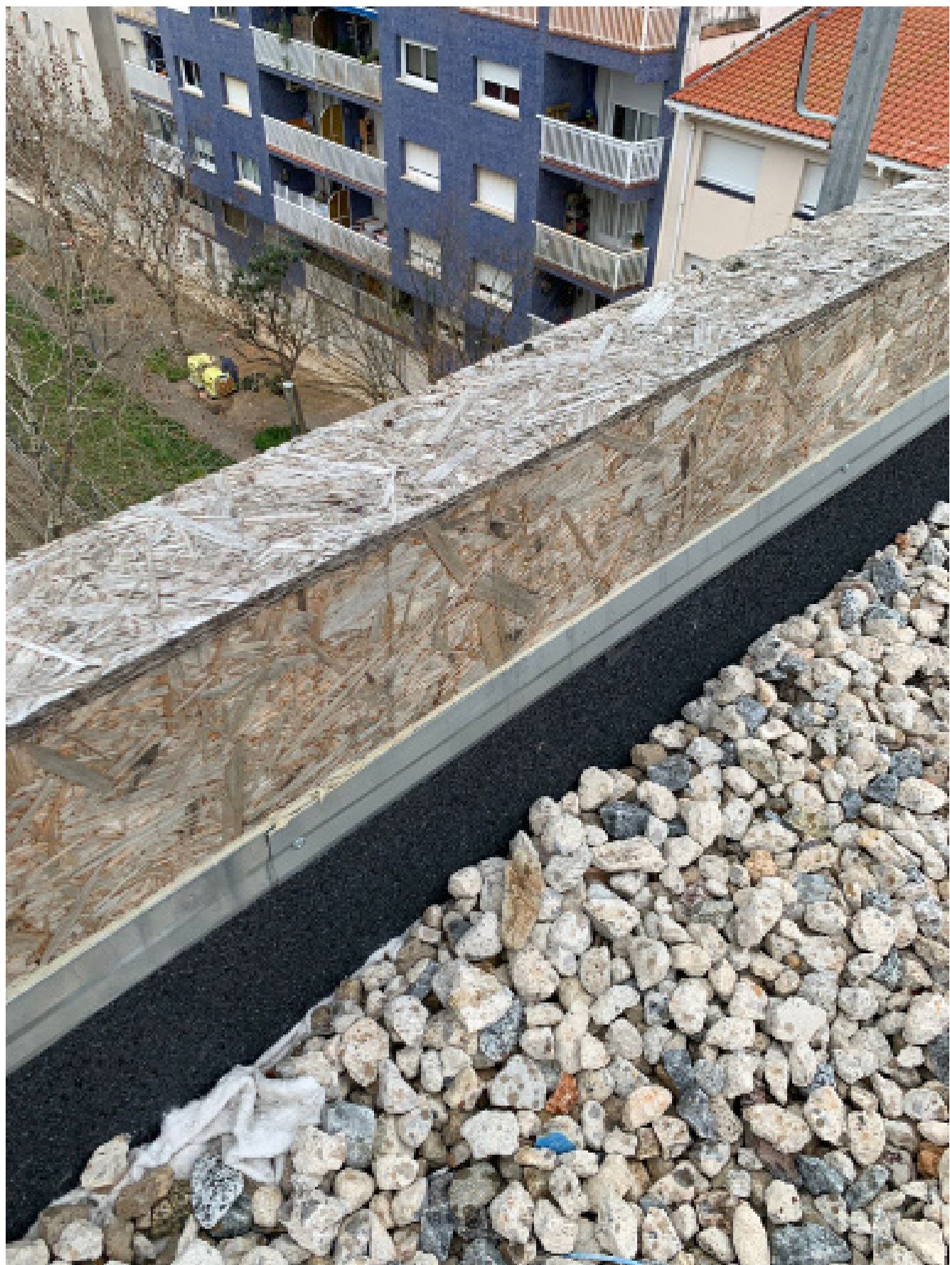
Muret de coberta: refer plaques en horitzontal, plaques en vertical es mantenen.
