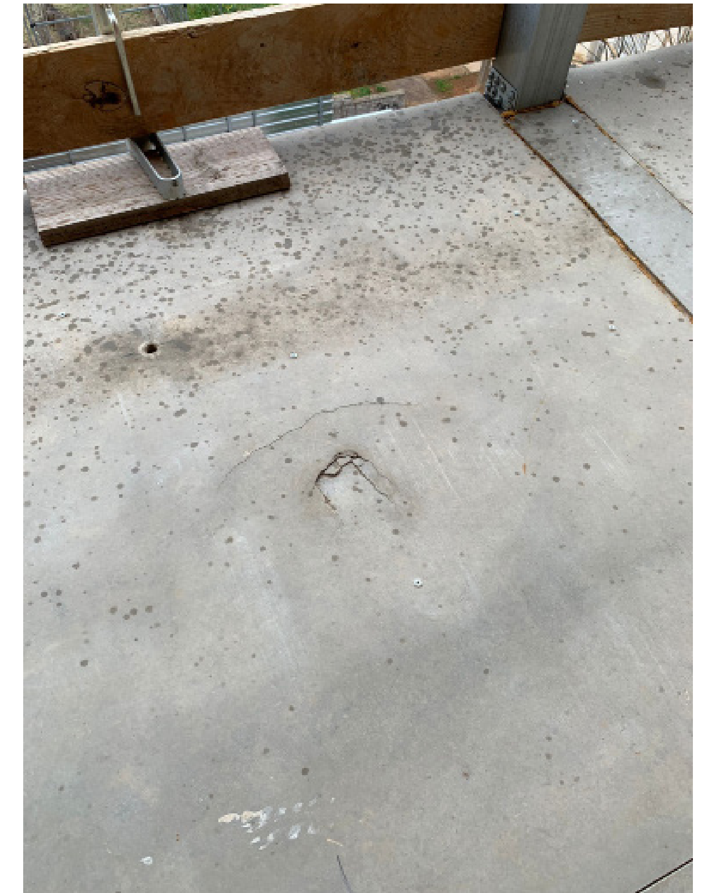
Trencament per impacte de la placa de fibrociment.
