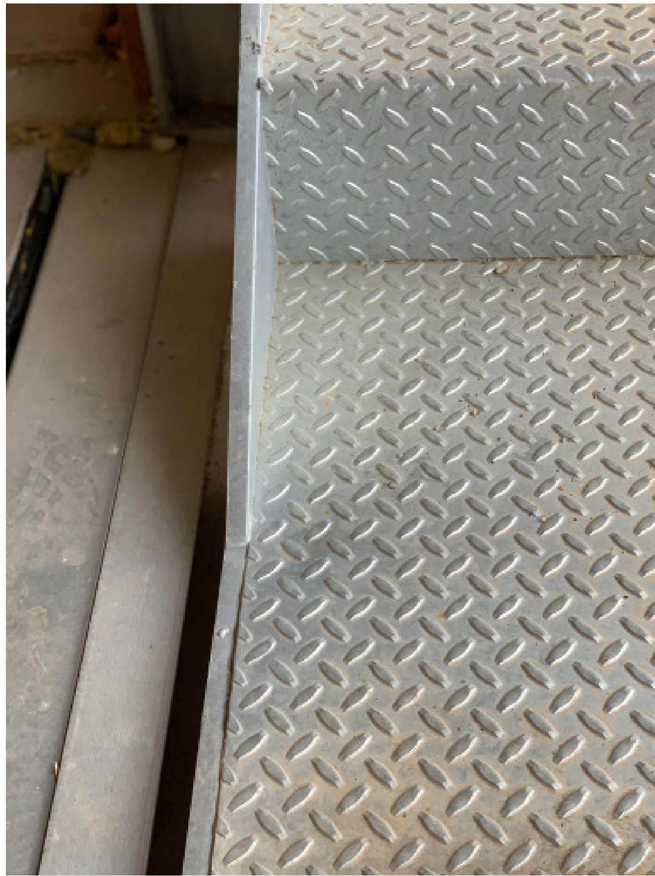
S'ha d'estudiar com es col·loca la xapa de l'escala: en alguns punts es plega aper damunt de l'estructura de l'escala i en d'altres es talla abans.
